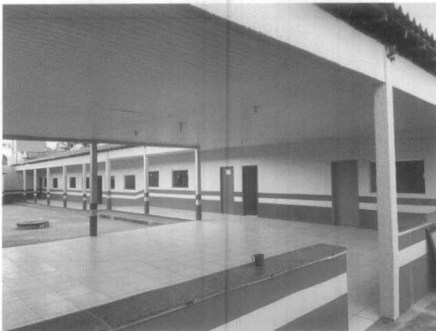
Imagem 10 – Recuperação de reboco interno, substituição de revestimento cerâmico e pintura interna da escola.
