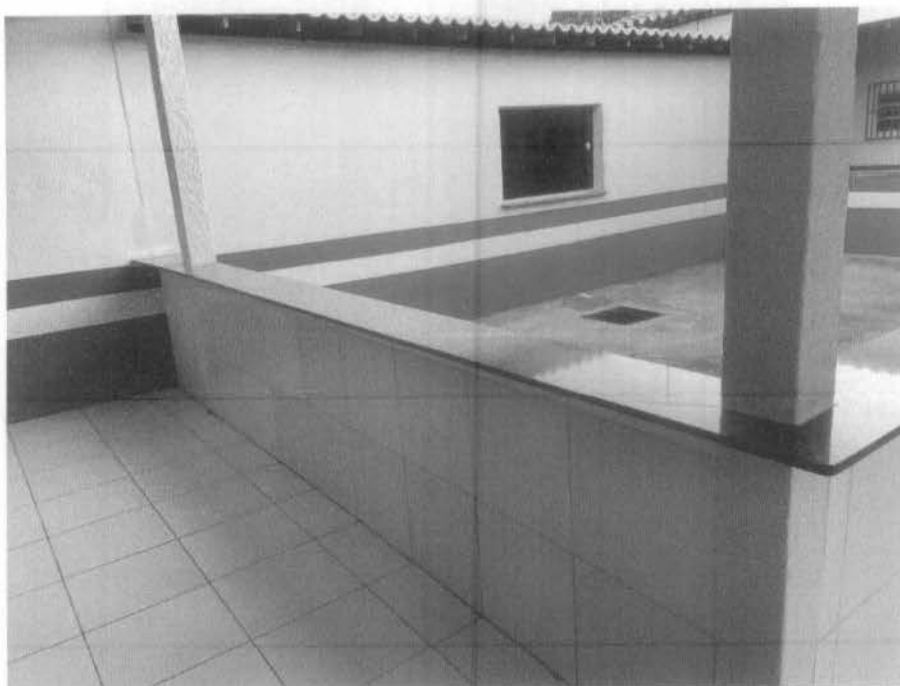
Imagem 13 – Instalação de peitoril de granito na mureta da escola.
