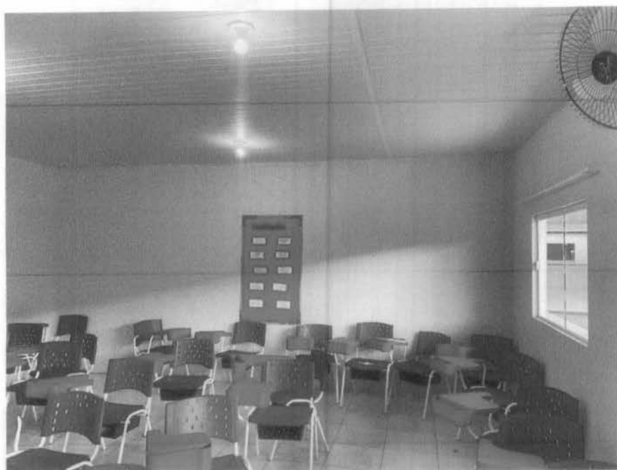
Imagem 17 – Recuperação de reboco interno e pintura interna.
