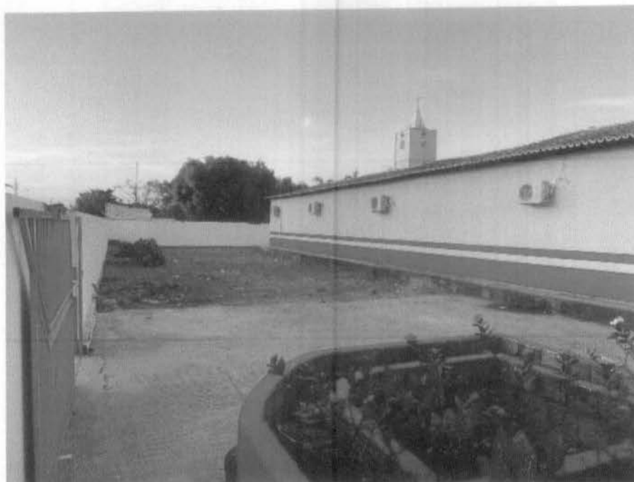
Imagem 7 – Recuperação de reboco externo e pintura externa da escola.
