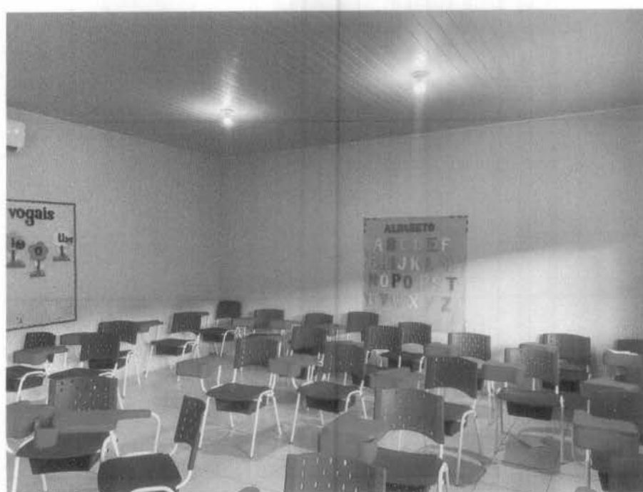
Imagem 16 – Recuperação de reboco interno e pintura interna.
