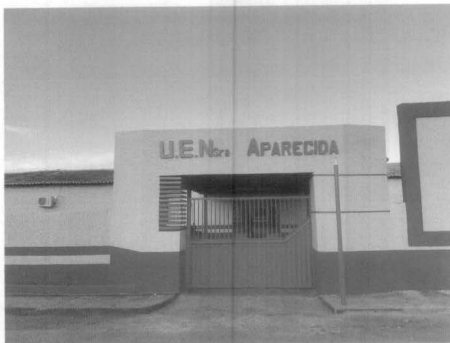
Imagem 1 – Pintura da fachada da escola.
