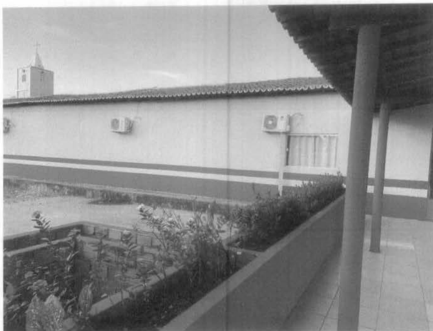
Imagem 5 – Pintura externa e substituição de piso cerâmico na estrada da escola.
