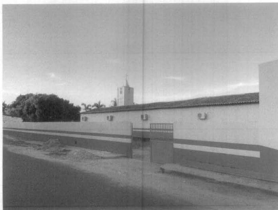
Imagem 2 – Pintura da fachada da escola.
