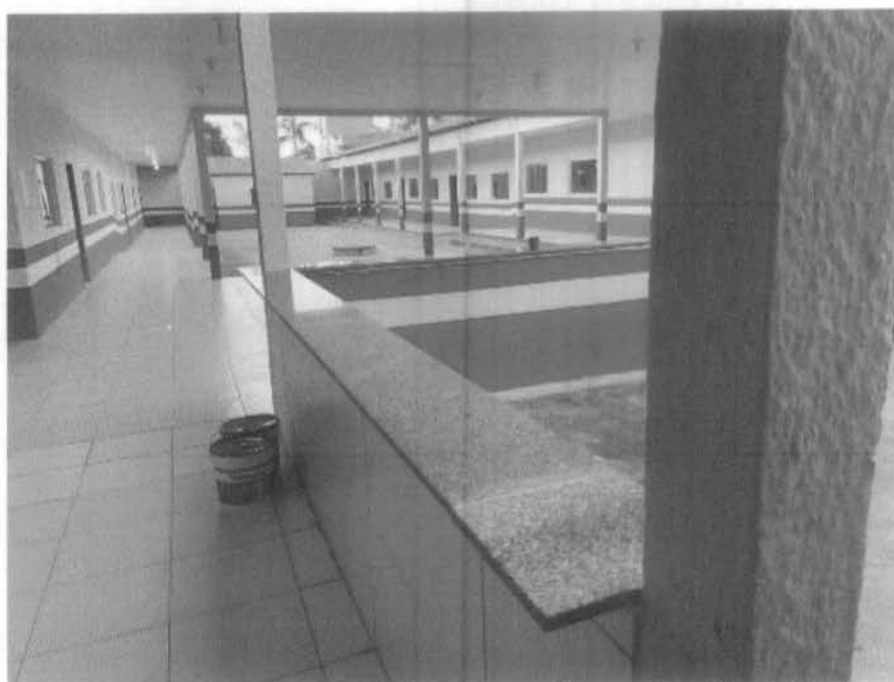
Imagem 12 – Instalação de peitoril de granito na mureta da escola.
