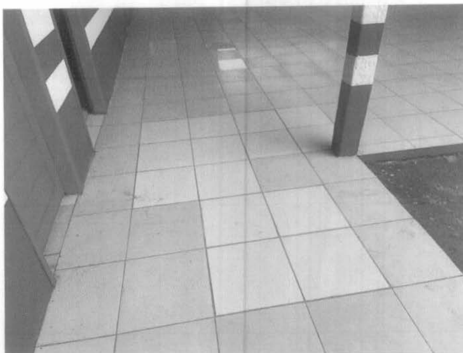
Imagem 15 – Substituição de revestimento cerâmico, na circulação da escola.
