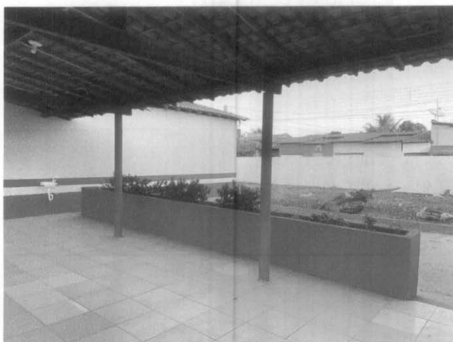
Imagem 4 – Pintura externa e substituição de piso cerâmico na estrada da escola.
