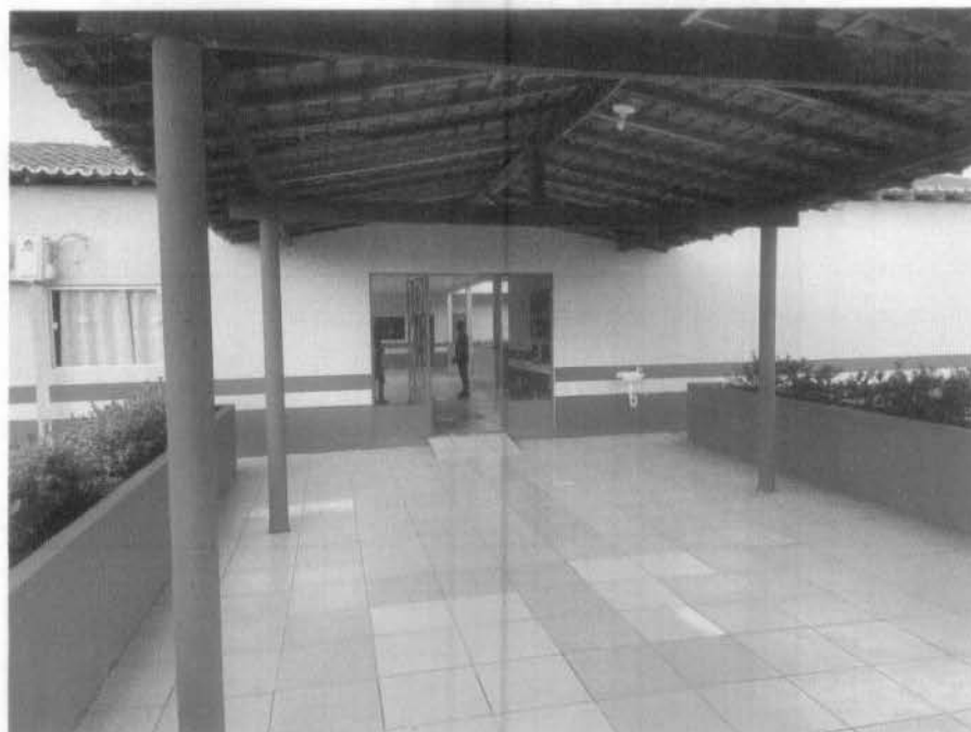
Imagem 6 – Pintura externa e substituição de piso cerâmico na estrada da escola.
