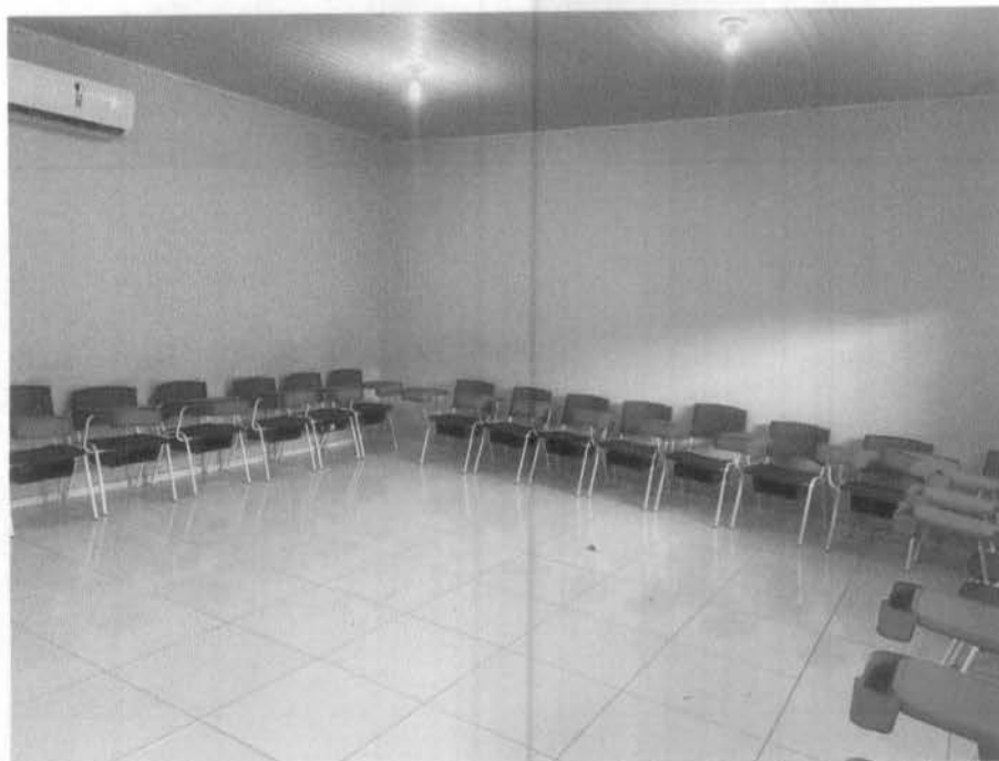
Imagem 19 – Substituição do piso cerâmico, recuperação de reboco interno e pintura interna.
