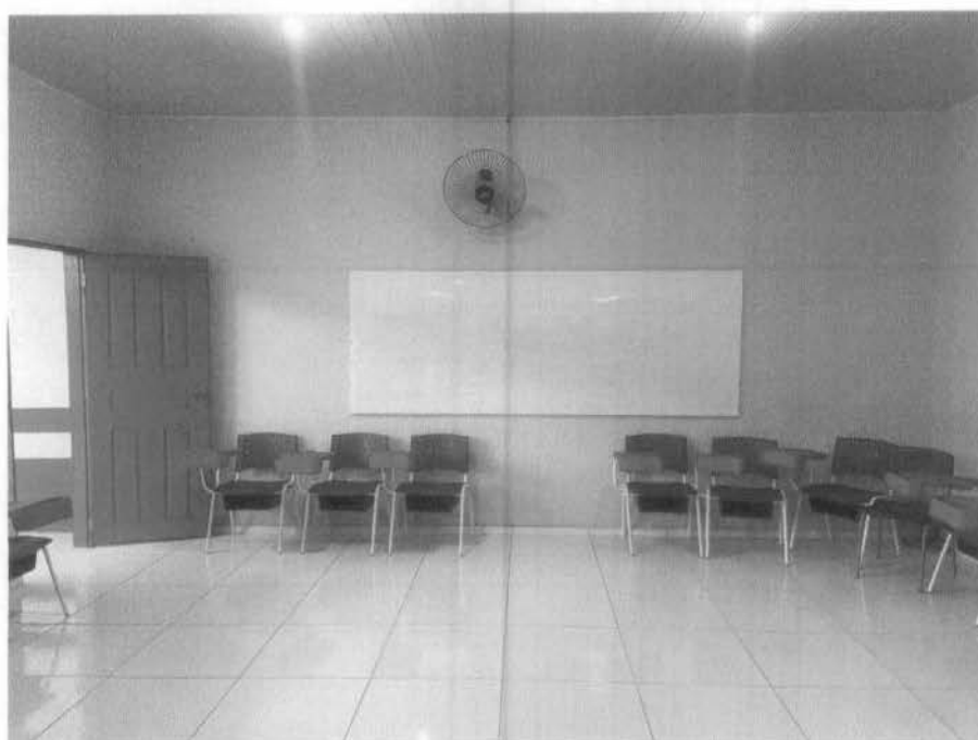
Imagem 18 – Substituição do piso cerâmico, recuperação de reboco interno e pintura interna.
