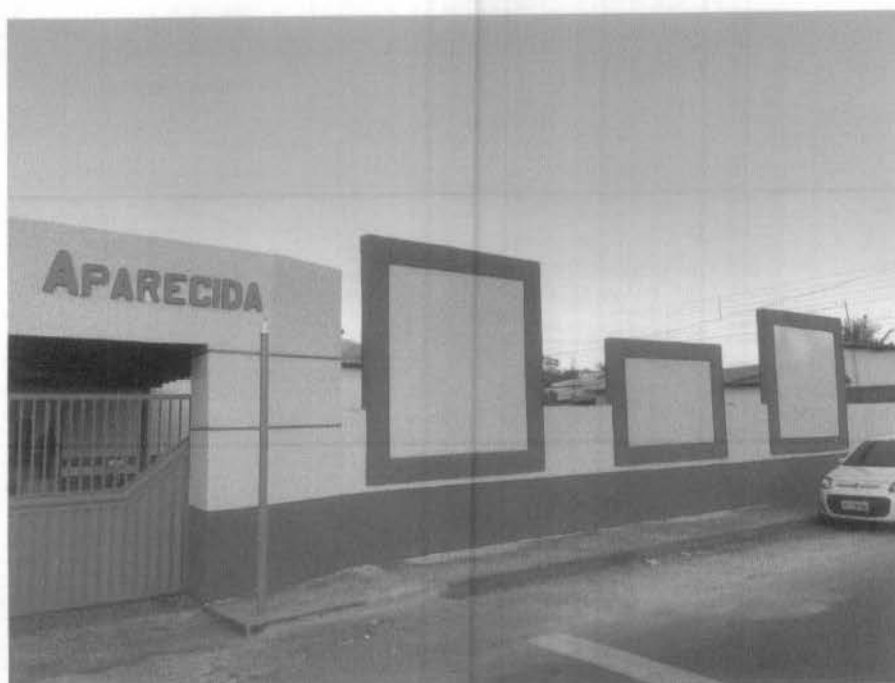
Imagem 3 – Pintura da fachada da escola.
