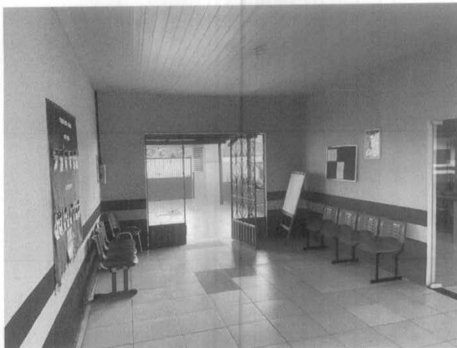
Imagem 9 – Recuperação de reboco interno, substituição de revestimento cerâmico e pintura interna da escola.
